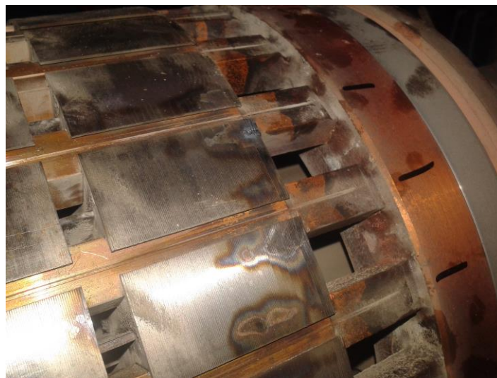
Рис.3. Ротор асинхронного электродвигателя с дефектами ротора.
